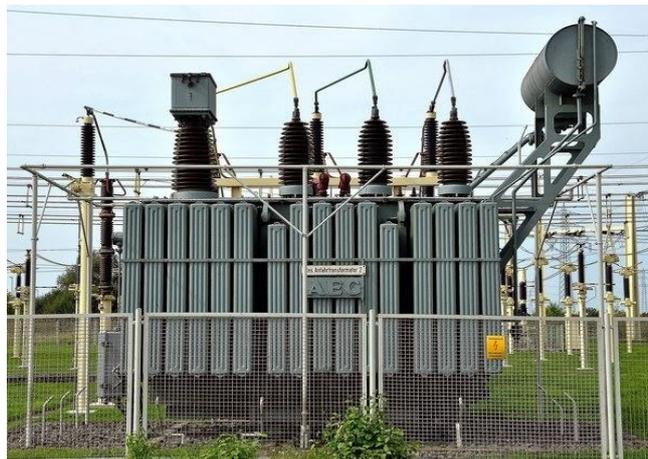
Gambar : Transformator daya
