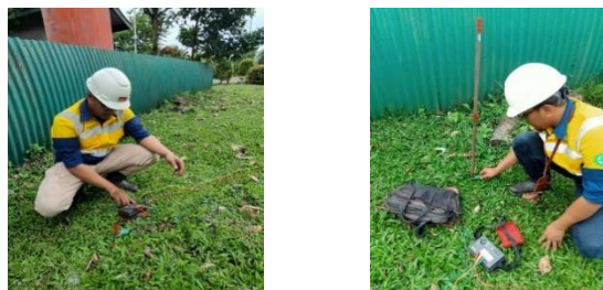
Gambar 3.1. Proses Pengukuran Resistansi Pentanahan
