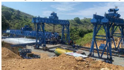
Gambar 5. Peluncuran Girder menggunakan Portal Gantry
