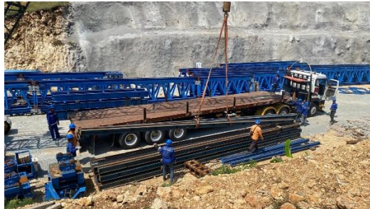
Gambar 7. Pengangkatan girder
