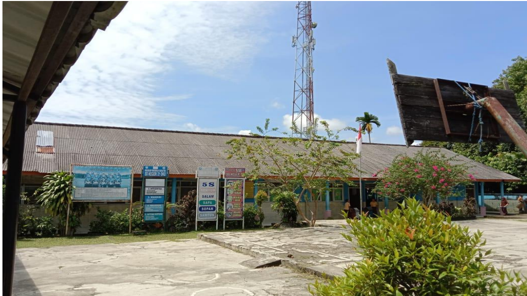
Gambar 4. Foto Dokumentasi Gedung Ruang Kelas
